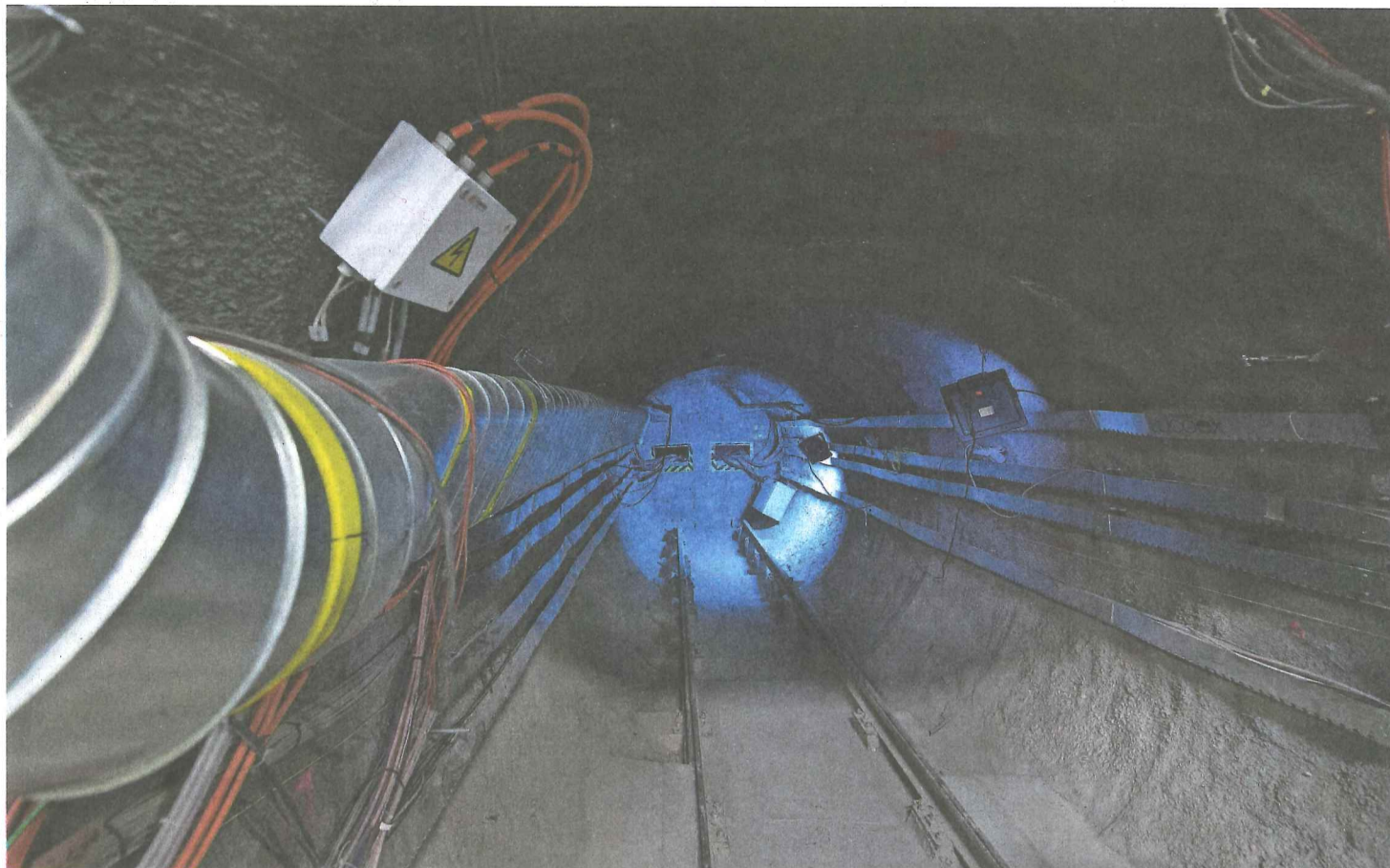
Ein Stollen im Opalinuston im Felslabor Mont Terri: Wie die schwarze Spinne bei Gotthelf soll der Atommüll in ein Loch gesperrt werden.
